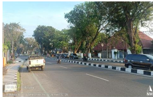
Gambar 2. Kondisi Eksisting Lahan Parkir Bahu Jalan (Puskesmas Merdeka)
