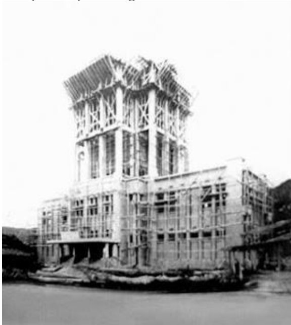
Gambar 3: Proses Pembangunan Watertoren 1929-1931
