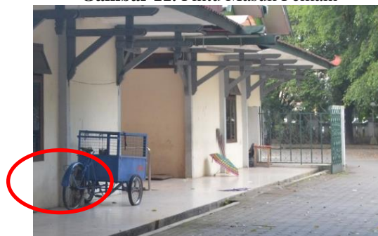
Gambar 12. Selasar menuju Pintu Masuk Pemain
