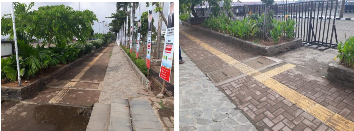
Gambar 6. Jalur Pemandu yang tidak terdapat tanda untuk berbelok atau berhenti Sumber: Penulis, 2018
