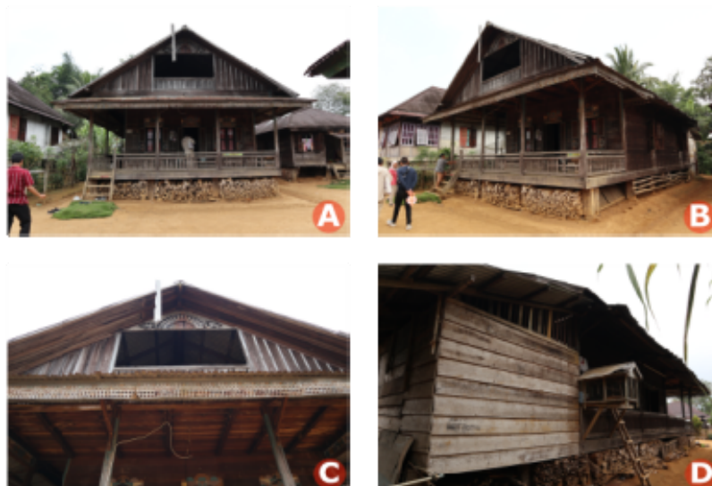
Gambar 1 Rumah bu Kabat ; a) tampak depan, b) tampak samping, c) detail atap, dan d) tampak belakang
