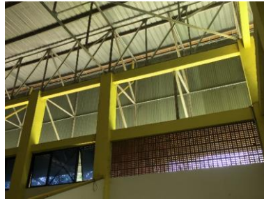
Gambar 4. Ventilasi pada Gymnasium UI (Sumber: Penulis, 2019)
