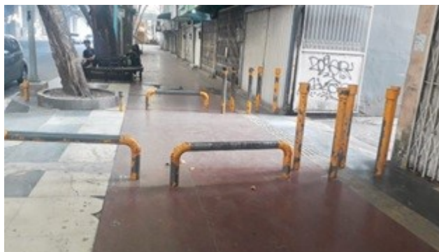
Gambar 11. Bollards yang berada di trotoar Sudirman Walk
