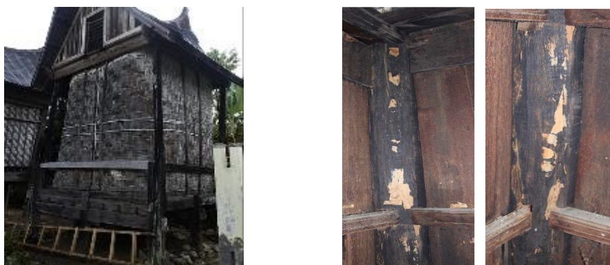
Gambar 4. Perubahan warna pada anyaman bamboo (kiri); Pengelupasan kulit pada tiang kayu (kanan)
