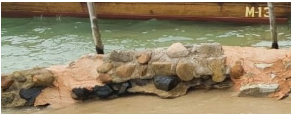
Gambar 4. Struktur Groin Permeable (Sumber : Penulis, 2022)
