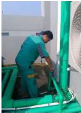
Gambar 23. Pengaturan Katup (Valve) Distribusi pada jaringan pipa air ( plumbing )
