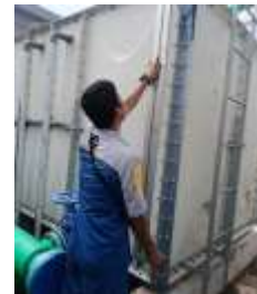
Gambar 20. Pemeriksaan level air bersih pada Tangki Fiber Reinforced Plastic (FRP)
