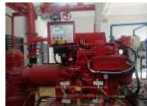
Gambar 7. Unit Pompa Hydrant Utama (Pompa Pemadam Kebakaran)
