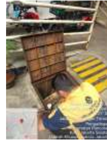
Gambar 18. inspeksi dan pembersihan Bak Kontrol Pembuangan Air Kotor (Manhole)
