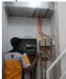
Gambar 5. Pemeriksaan Panel Kontrol Lift Servis yang dilengkapi VFD ( Variable Frequency Drive )
