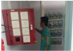
Gambar 3. Pemeriksaan rutin pada Main Control Fire Alarm (MCFA) dan panel meteran unit
