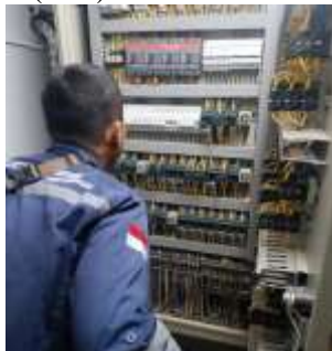
Gambar 10. Inspeksi Panel Distribusi Listrik (LVMDP/SDP) oleh petugas mekanikal elektrikal
