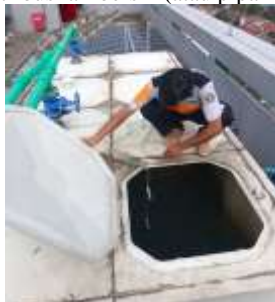
Gambar 25. Pemeriksaan Sensor Level Air di dalam tangka
