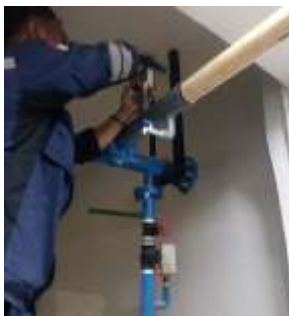
Gambar 24. Pengecekan dan perbaikan instalasi pipa distribusi air bersih (atau pipa riser)
