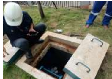
Gambar 21. Pemeriksaan rutin Meteran Utama dan Instalasi Sambungan PDAM
