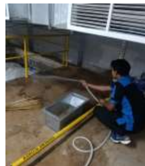
Gambar 22. pembersihan rutin pada area dan komponen Instalasi Pengolahan Air Limbah (IPAL) / STP
