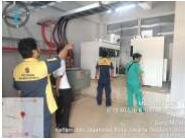
Gambar 16. Instalasi Transformator (Trafo) dan Panel Utama Distribusi Listrik (LVMDP)
