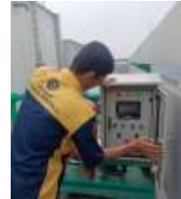
Gambar 19. Petugas Mekanikal Elektrikal melakukan inspeksi pada Panel Kontrol Pompa Air untuk memastikan distribusi air bersih dan tekanan air optimal
