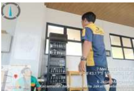
Gambar 11. Pemeriksaan rutin Rak Peralatan (Rack Server) yang menampung receiver dan splitter untuk sistem MATV (Master Antenna Television)
