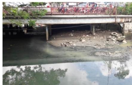
Gambar 6. Kondisi DAS yang banyak endapan sedimen
