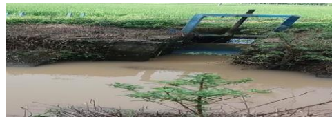
Gambar 2 Bangunan bagi saluran primer
