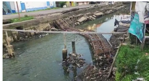
Gambar 1. Kondisi Aliran Sungai Bendung
