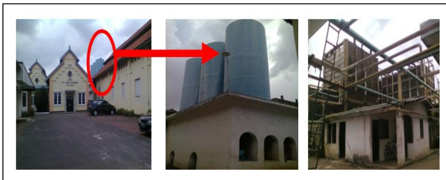
Gambar 2. Water treatment dibelakang pabrik (Sumber: dokumentasi pribadi)
