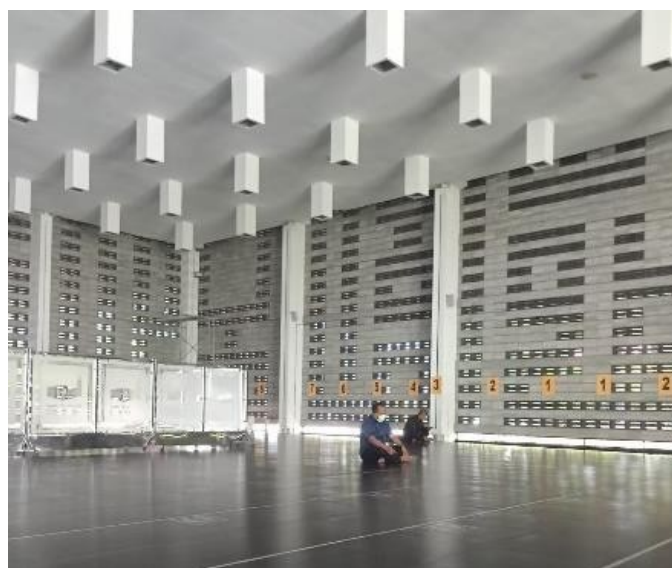
Gambar 9. Situasi tampak plafond masjid
