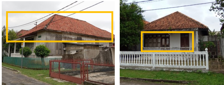
Gambar 8. Material Bangunan Rumah Besak (Sumber : Dokumentasi Lapangan, 2023)
