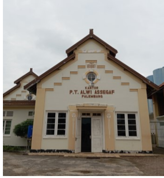
Gambar 2. Tampak Depan Kantor P.T. Alwi Assegaf (Sumber : Dokumentasi Lapangan, 2023)
